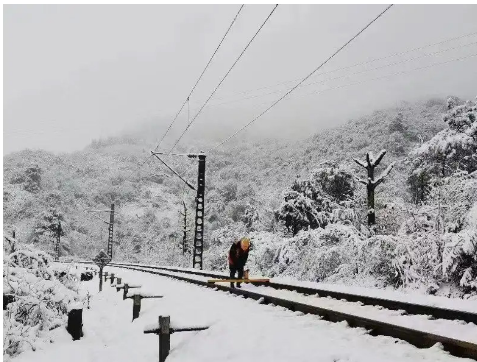
Рис. 1. Обледенение контактной сети на ж. д. линиях Китая (Гуйян) [2]
