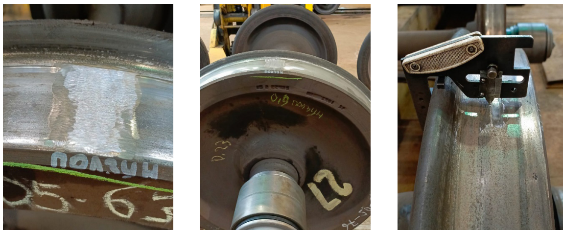
Рис. 5. Фото дефектов поверхности катания (фото — А. А. Шамрай)
