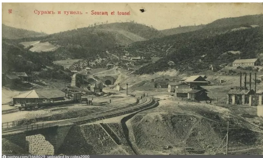
Рис. 3. Сурамский перевал и тоннель
