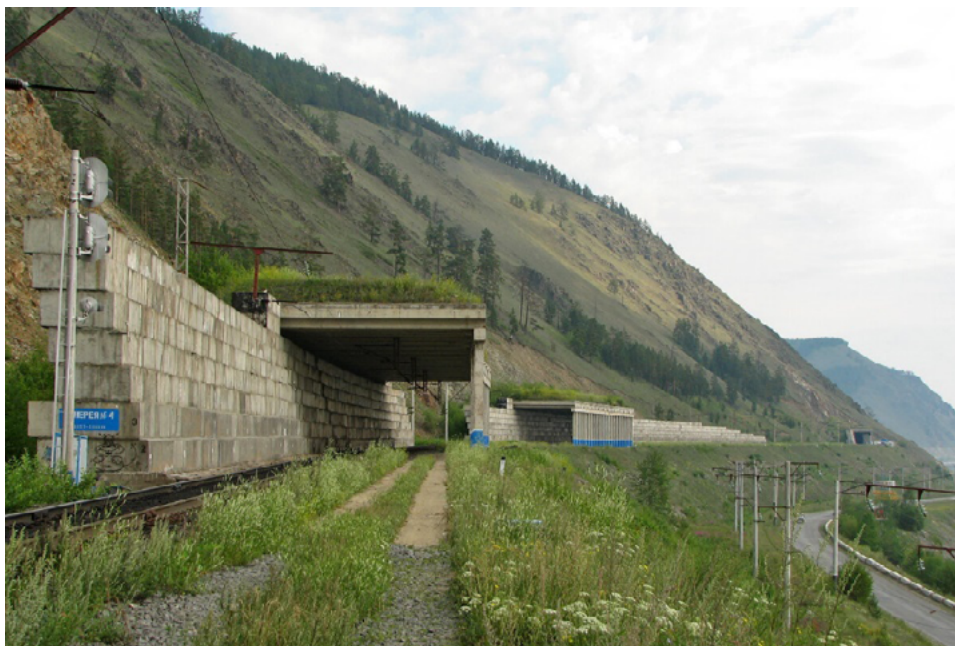
Рис. 6. Пример защитной галереи на БАМе
