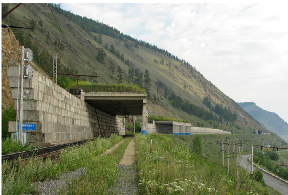
Рис. 6. Пример защитной галереи на БАМе
